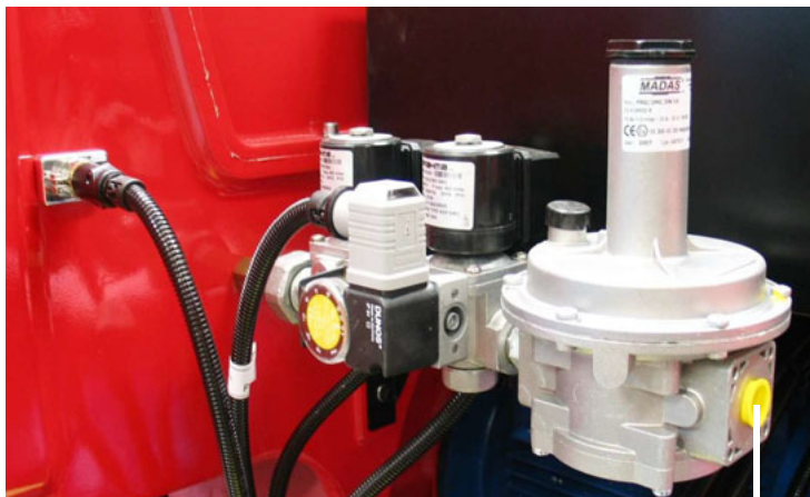
подсоединение к сети распределения газа
