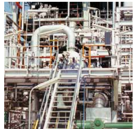
Установка рекуперации серы
