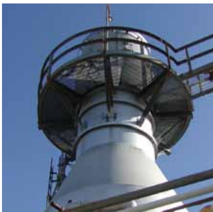
Установка утилизации отходящих газов
